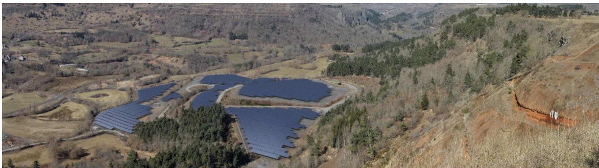
Figure 41 : Extrait de l'étude d'impact du projet de parc photovoltaïque des Martines - ENGIE Green - Septembre 2018
