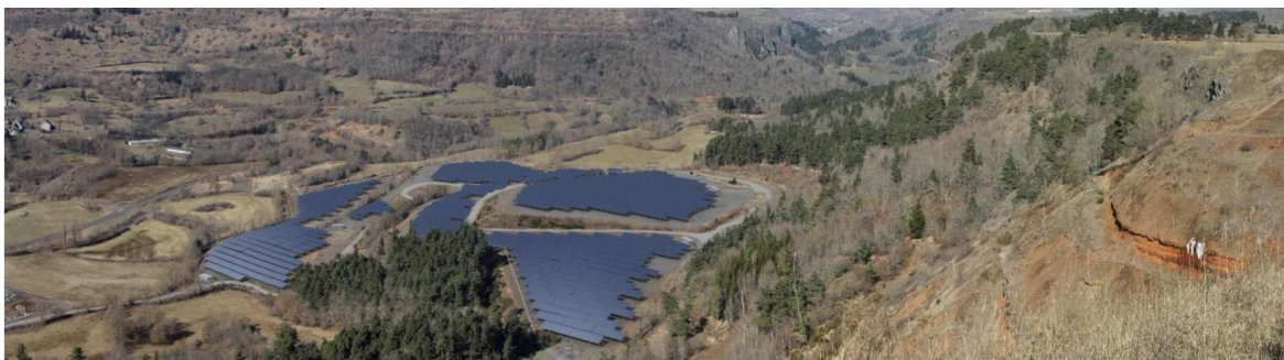
Figure 45 : Extrait de l'étude d'impact du projet de parc photovoltaïque des Martines - ENGIE Green - Septembre 2018
