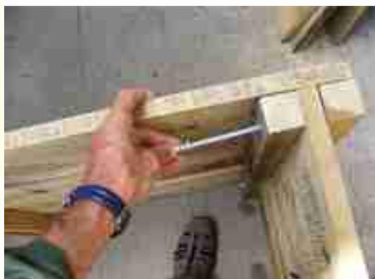
Placer vos parois comme indiqué sur la photo et percer en une seule fois les deux montants et la planche en haut, en bas et au milieu sur les deux parois arrière.
